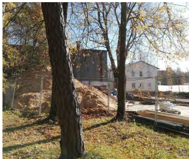
Ropažu novada domes ēka un jaunās piebūves būvniecība
