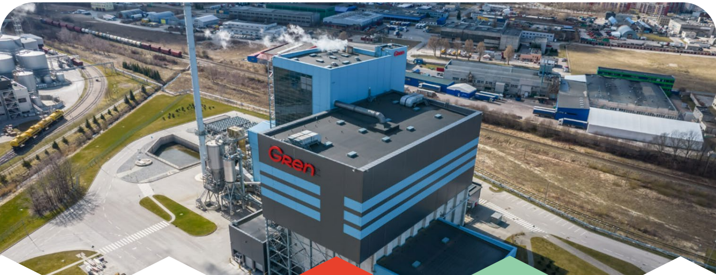
Klaipēdas enerģijas reģenerācijas no atkritumiem kogenerācijas stacija
